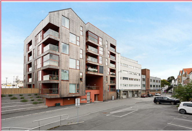
Inngangsparti og garasje i lukket anlegg
