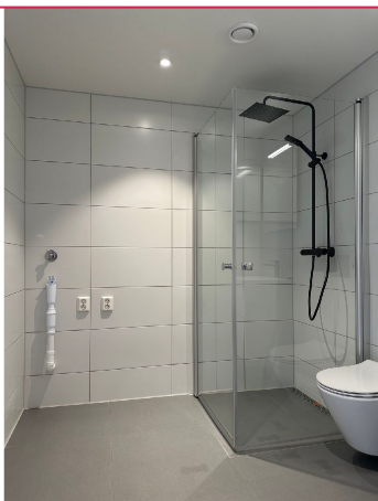
Flislagt bad med opplegg for vaskemaskin
