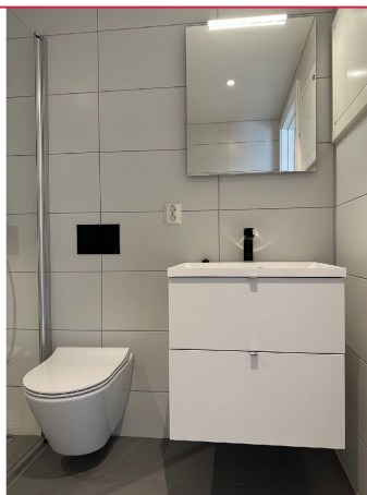
Veggmontert toalett på bad
