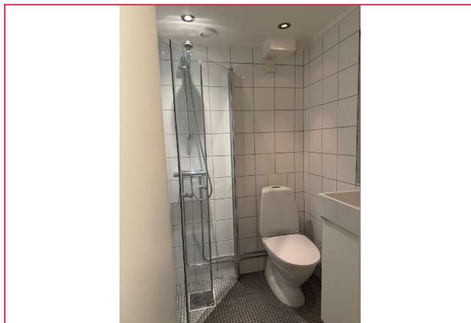
Pent, flislagt bad med wc, dusj og servant.
