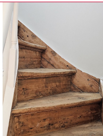
Trapp opp til loftsetasje
