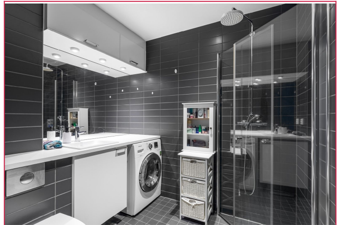
Baderom i flislagt utførelse med malt tak. Det er varmekabler i gulvet.
