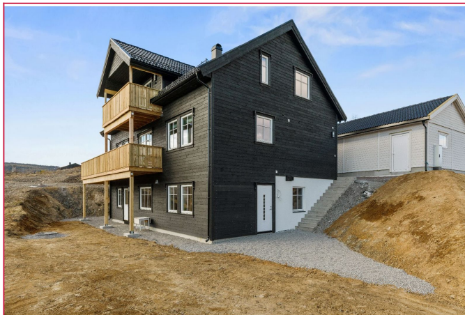
Fasade og uteplass (bildet er fra 2020)
