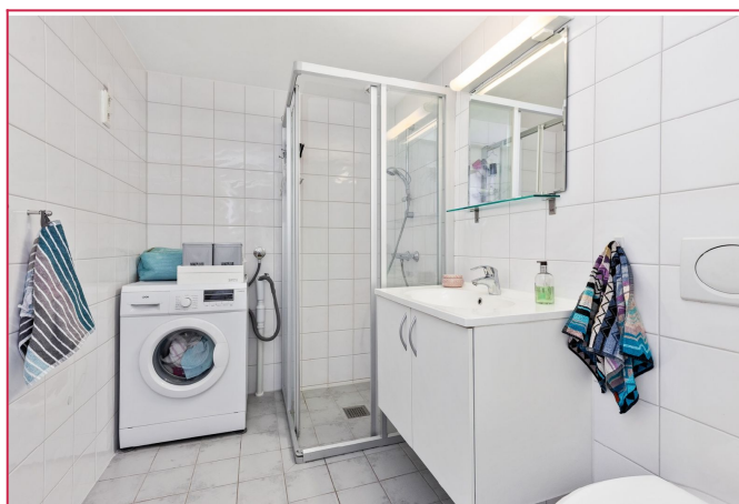
Varmekabler på bad.
