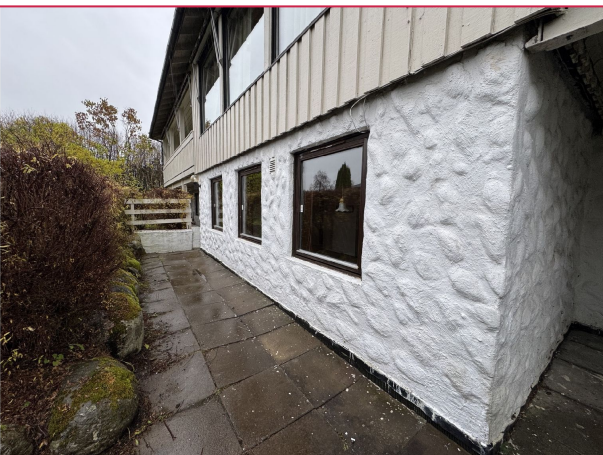
Trivelig inngangsparti med steinlagt gulv.
