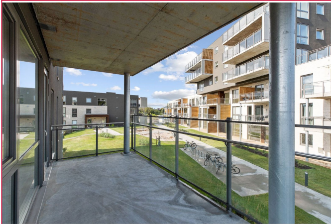
Romslig overbygget balkong
