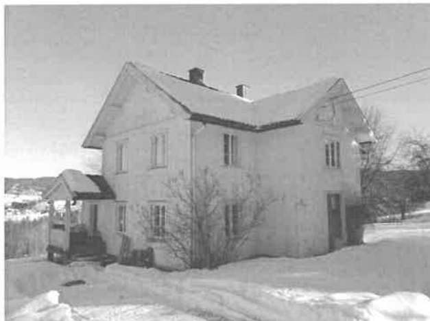
Nyere hovedinngang med takoverbygg på vestre side Eldre inngangsparti på søndre side.
