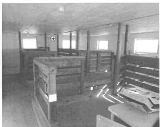
Fjøsdelene med betonggulv og betongtak
