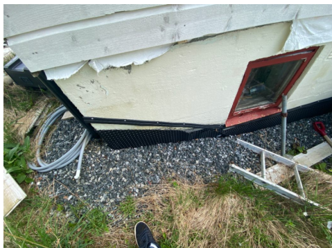
Bildet viser grunnmursplast som er strukket ut av klemplister.
