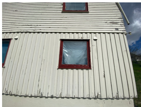
Bildet viser vindu.
