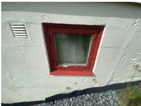
Bildet viser vindu.
