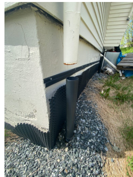
Bildet viser grunnmursplast som er strukket ut av klemplister.
