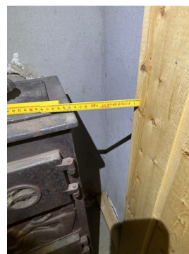
Avstand til brennbart materiale
