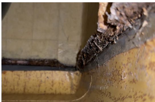
Fuktskader i nederkant av veggplater
