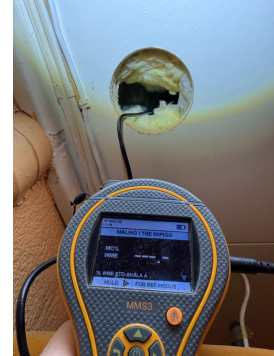
Hulltaking i underliggende konstruksjon
