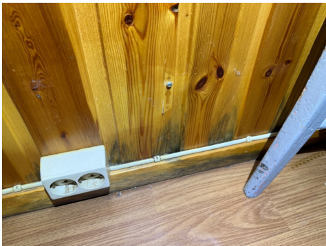
Nederkant av innvendig vegg
