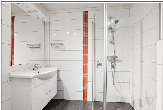
Pent flislagt bad med toalett, servant m/innredning og hjørnedusj
