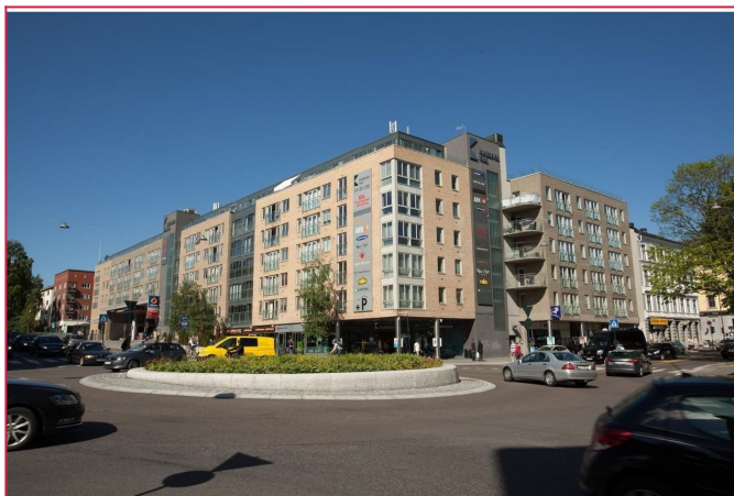
Kiellands hus med alt du trenger til dagligvarehandel
