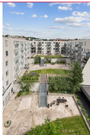
Pent opparbeidet bakgård
