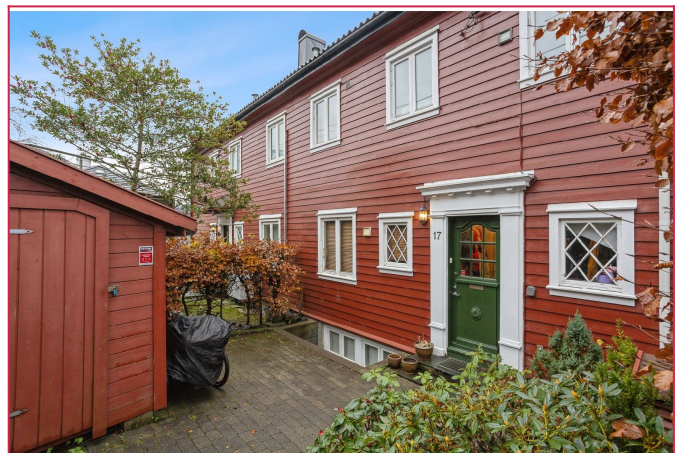
Fasade.Inngangsparti til boligen på andre siden av bygget.
