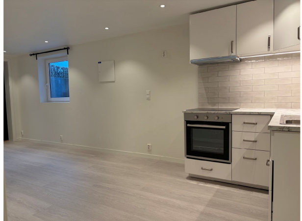
Downlights i tak, varmekabler i gulv.
