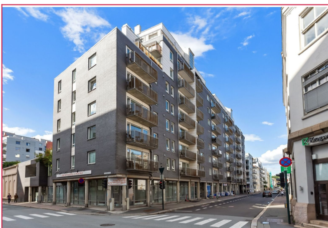
Fasade. Rema 1000 ligger i samme bygg som leiligheten.
