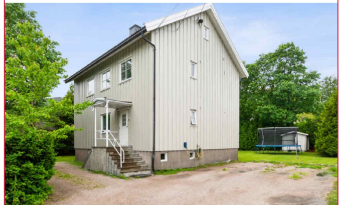
Fasade - felles inngang for leilighetene, parkeringsplass i oppkjørsel
