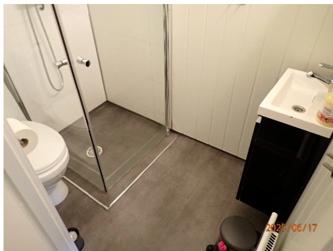
Seksjon 5: Bad/wc ved sørøst kontorrom.
