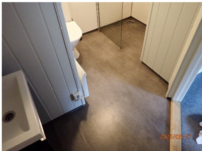
Seksjon 5: Bad/wc som må rives ved ombygging av inngang.
