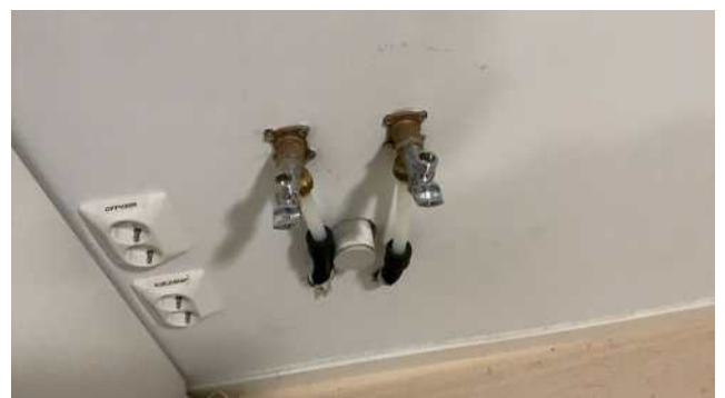
Røropplegg for fremtidig innredning
