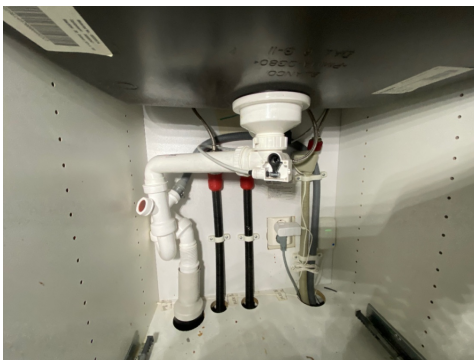
kontroll av røropplegget
