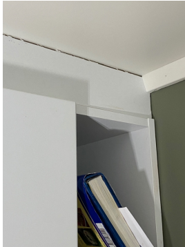
Glippe mellom tak og dekkside.
