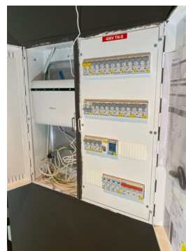
Sikringsskap med automatsikringer.
