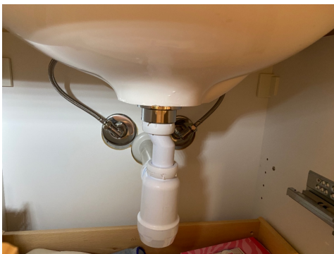
Kontroll av røropplegget.
