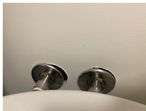
Rørgjennomføring mot vegg fra VVS bereder på boden.
