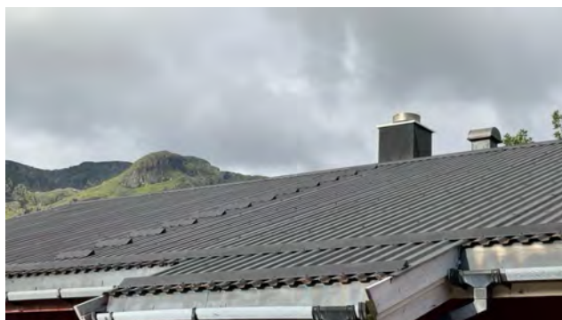
Snøfangere og trinn montert på tekkingen.
