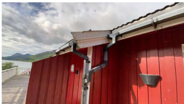
Utsnitt av takrenner og -nedløp.
