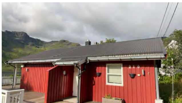
Utsnitt av takteking - flate mot sørøst.
