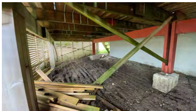
Utsnitt av bærekonstruksjon og fundamentering av terrasse.
