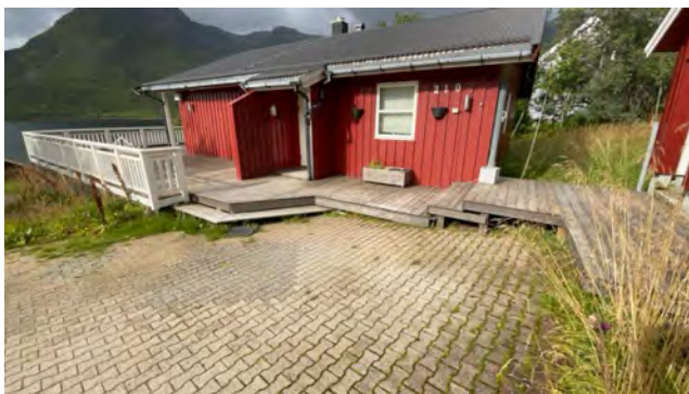
Utsnitt av trapper ved inngang og uthus,
