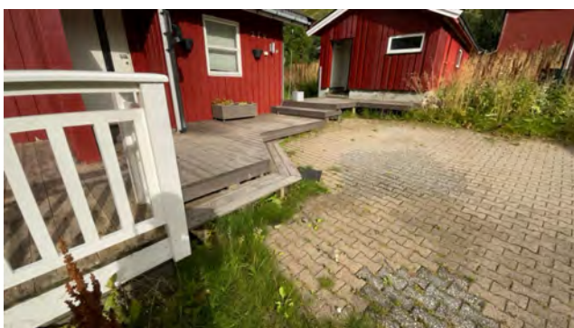
Utsnitt av trapper ved inngang og uthus,
