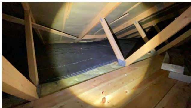
Utsnitt av takkonstruksjoner.
