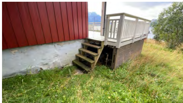
Trapp fra terrasse til terreng ved fasade mot nordvest.
