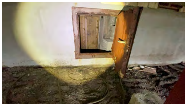
Tilkomst via luke i grunnmur.
