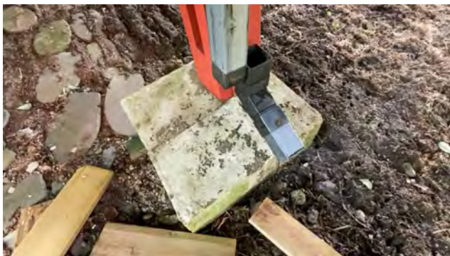
Utsnitt av taknedløp hvor utkaster ikke er tilkoblet nedløp.
