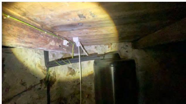
Varmtvannstank tilkobling med stikk.
