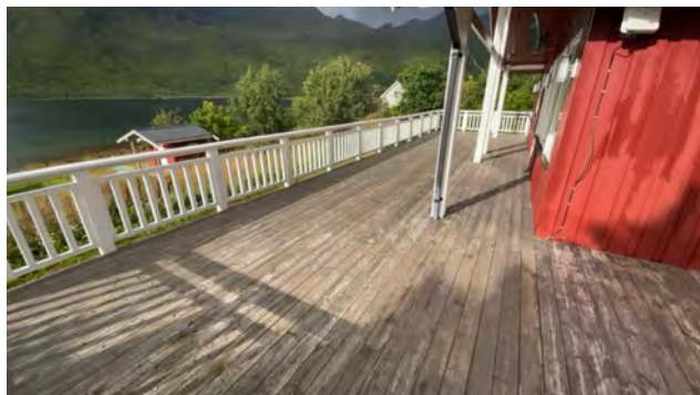
Utsnitt av terrasseareal ved fasade mot sørvest.
