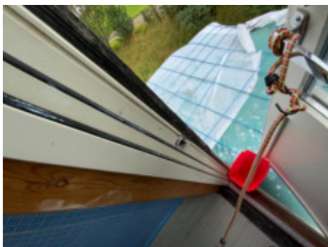
Harde - utette pakninger
