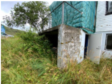
Betonginngangsparti har slitasje - alder og sprekker.
