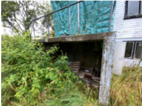
Betonginngangsparti har slitasje - alder og sprekker.
