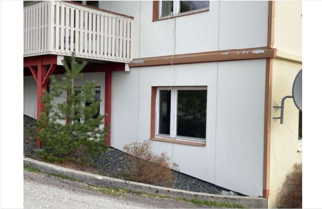
Lekkasje inn i bygg på grunn av feil detalj på fasadeplate og beslag
