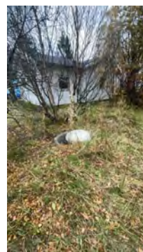
Kum som ligger inne på tomten med vann og avløp til nabo
