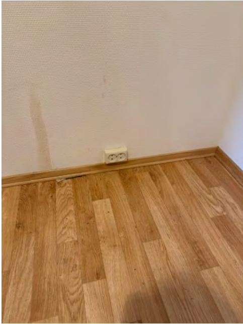
Bilde 2 Ujordet stikkontakt
