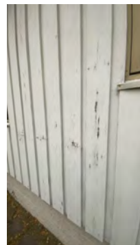
Sprukne slitte overflater på fasade
