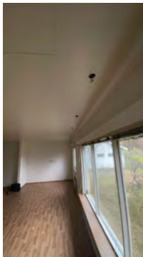
Flere el-bokser i stue mangler lokk.
