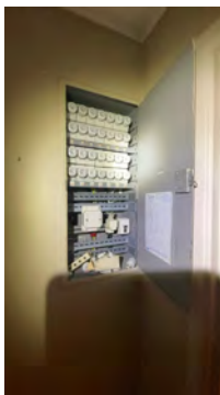
Flere el-bokser i stue mangler lokk.
