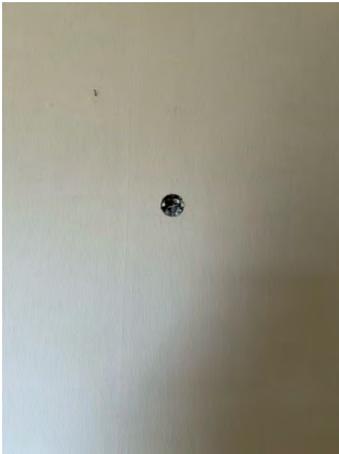
Bilde 1 Åpen veggboks på veggen i stue 1. etg
