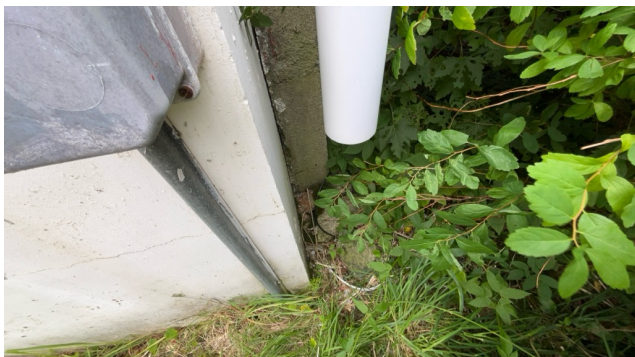
Nedløpsrør avsluttet rett på terreng
