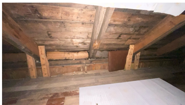
Takkonstruksjon i kryprom utenfor knevegger
