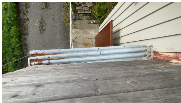
Taktekking under balkong av bølgeblekk
