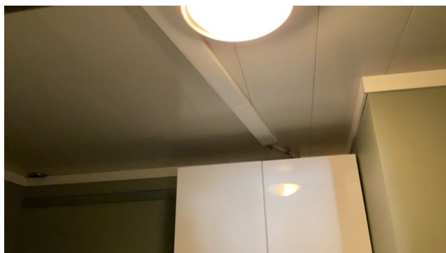
Vannledninger til bad er lagt i kanal i himlingen.
