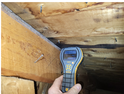
Fuktmåling i takkonstruksjon viste ingen forhøyede fuktverdier.
