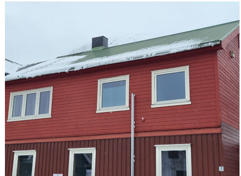
Taktekke mot øst.
