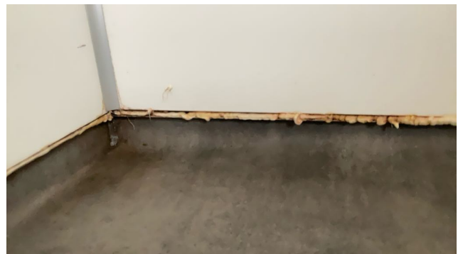
Ufagmessig arbeid med plater på vegg.
