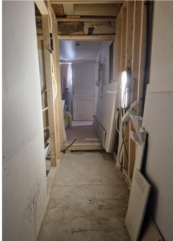
Uferdige arbeider i 1. etg
