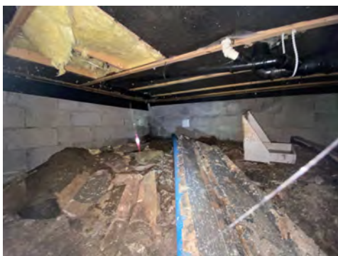
Bildet viser deler av krypkjeller.
