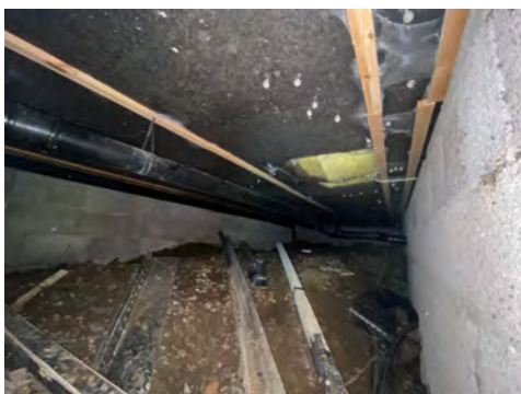
Bildet viser deler av krypkjeller.
