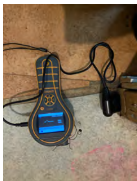
Bildet viser fuktmåling av vaskerom.
