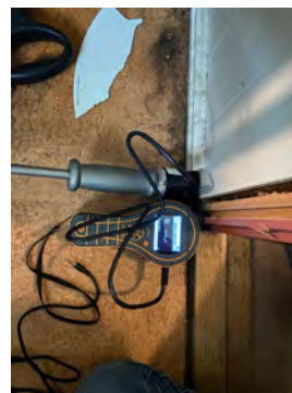
Bildet viser fuktmåling av bad.
