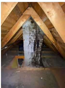
Bildet viser deler av takkonstruksjon.
