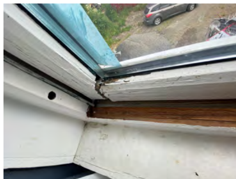
Bildet viser vindu.
