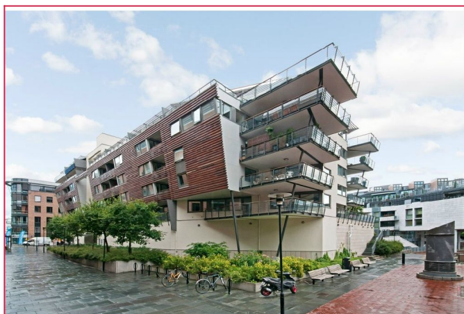
Fasade. Boligen ligger i byggets 7. etasje.
