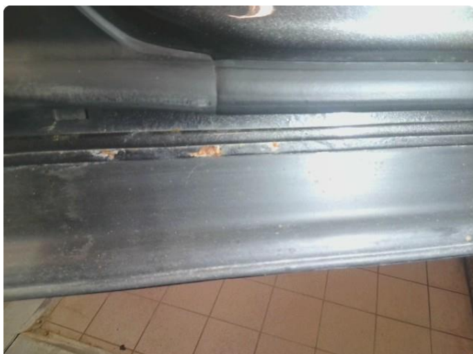
2.1 Rust i fals
