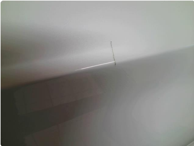
1.1 Ripe ned til grunning
