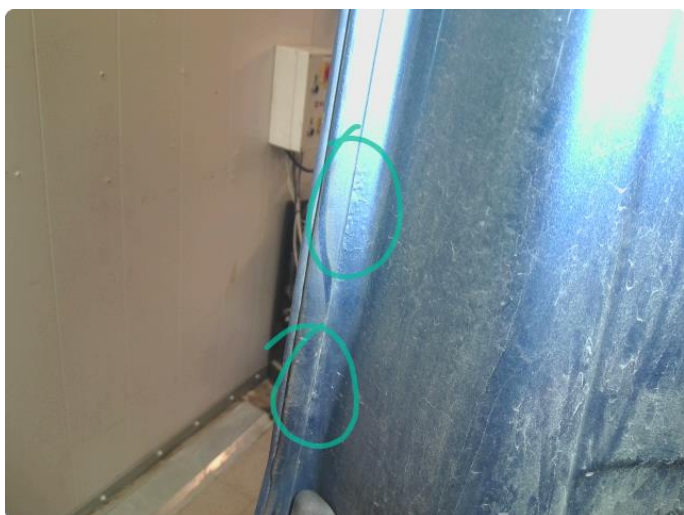
1.2 Rust/korrosjon
