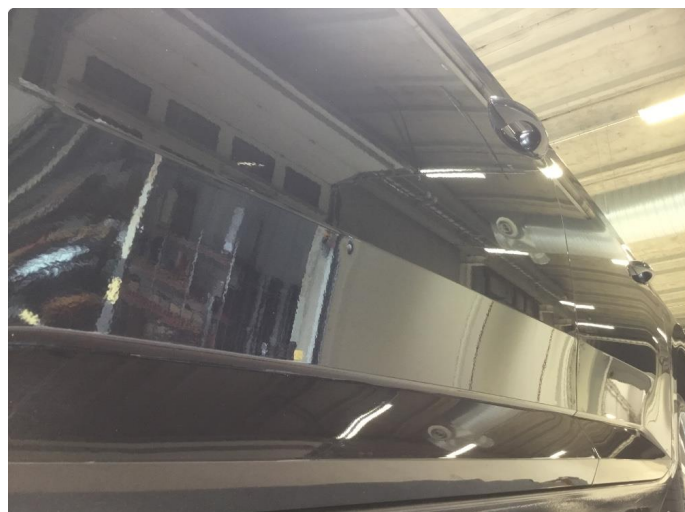
1.1 Bulk med lakkskade Venstre dør foran
