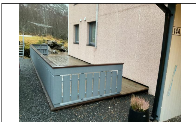
Felles markterrasse for inngang A ved fasade mot nordvest.
