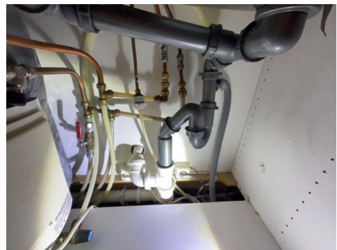
Utsnitt av avløpsrør i kjøkkenbenk.
