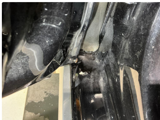
1.3 Venstre foran rust i fals
