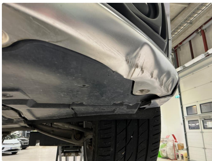
1.8 Nedre spoiler/diffuser skadet/bulket
