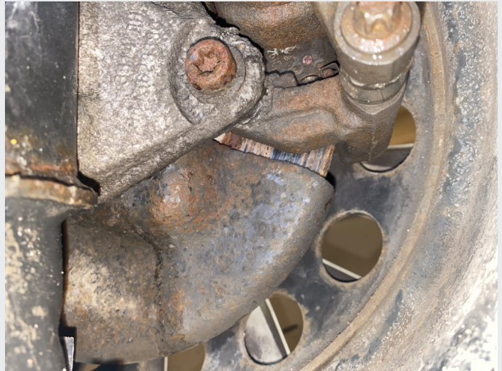
9.7 Rust skiver bak, spes høyre side
