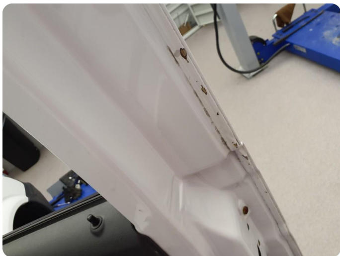
3.1 Øvrige feil Generelt mye riper, bulker, rust og noe steinsprut på hele bilen
