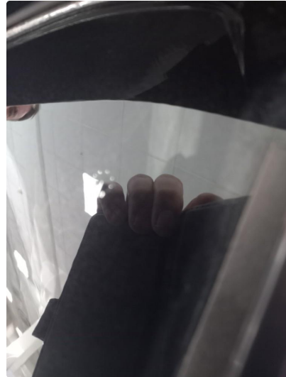
1.3 Steinsprut med rust nedre del
