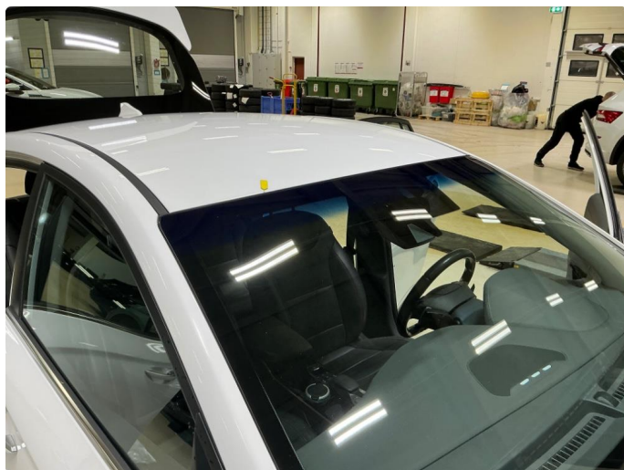
1.8 Steinsprutskade forkant tak
