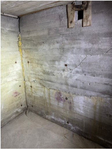
Synlige gjennomgangs bolter etter reparasjon av grunnmur.
