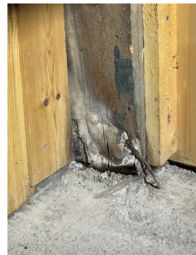
Stolpe til trapp støpt inn og står på grunn.
