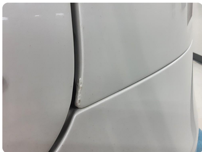
3.11 Ripe(r) ned til grunning
