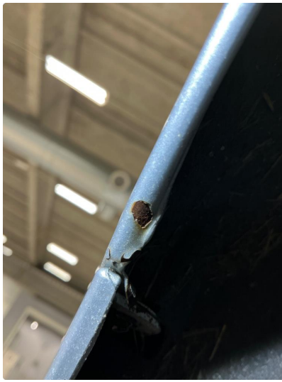
1.5 Rust Høyre bakskjerm
