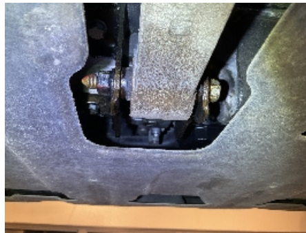
29. Utvendig tilstand motor
