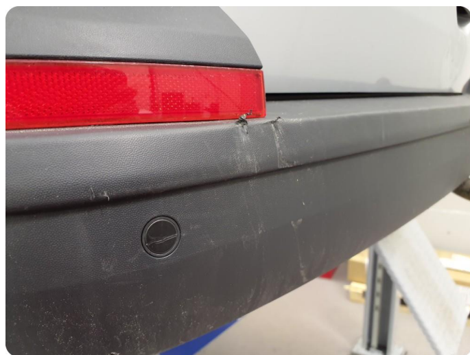
2.6 Skade Inkluderer flere riper og skader
