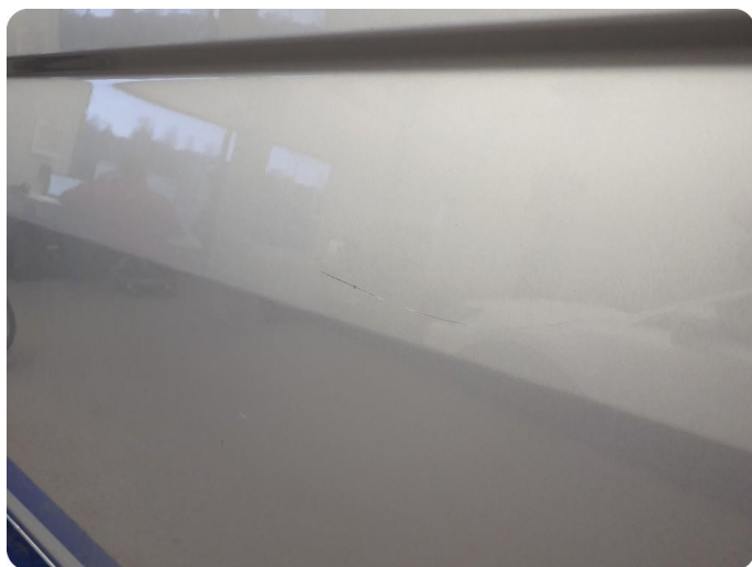
2.1 Bulk med lakkskade Inkluderer flere riper
