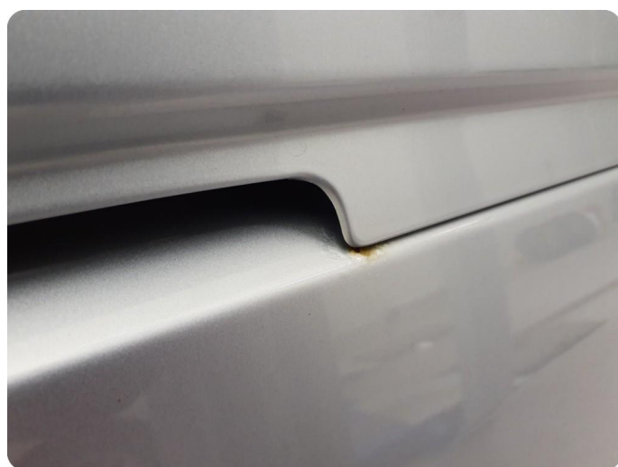
2.3 Rust Inkluderer flere riper
