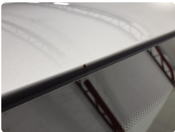
2.9 Steinsprut med rust
