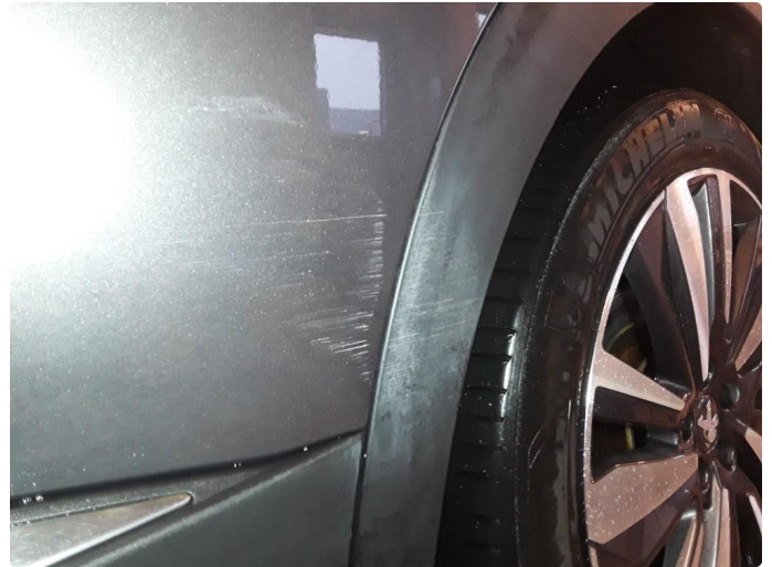
1.3 Noe riper på venstre hjulbue bak.
