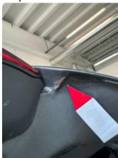
1.3 Noe korrosjon på bakluke.
