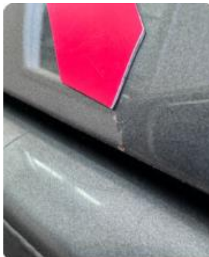
1.1 Noe riper innsteg venstre bak, Noe korrosjon og småbulker på alle dører, Korrosjon mellom fanger og bakskjerm begge sider, Korrosjon venstre bakskjerm.
