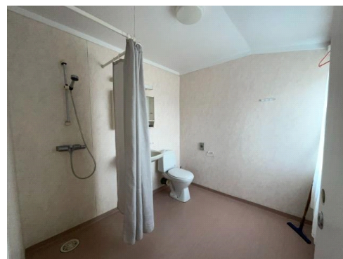
Enkle bad i hybler med gulvbelegg og baderomsplater/våtromstapet på vegger.
